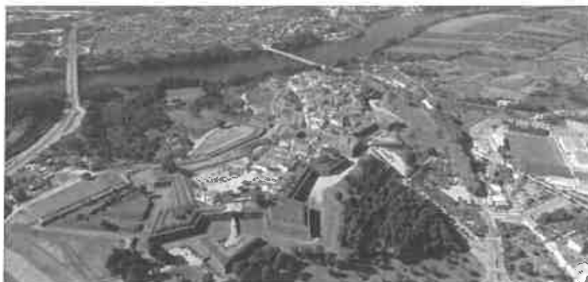
Figura 2. Vista Exterior das Muralhas
