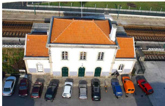
Figura 8.2. Aspecto da Estação de São Pedro da Torre.
